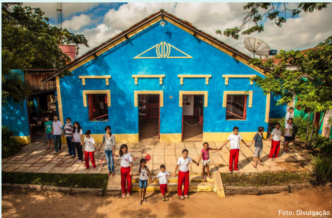
Fundação Casa Grande
